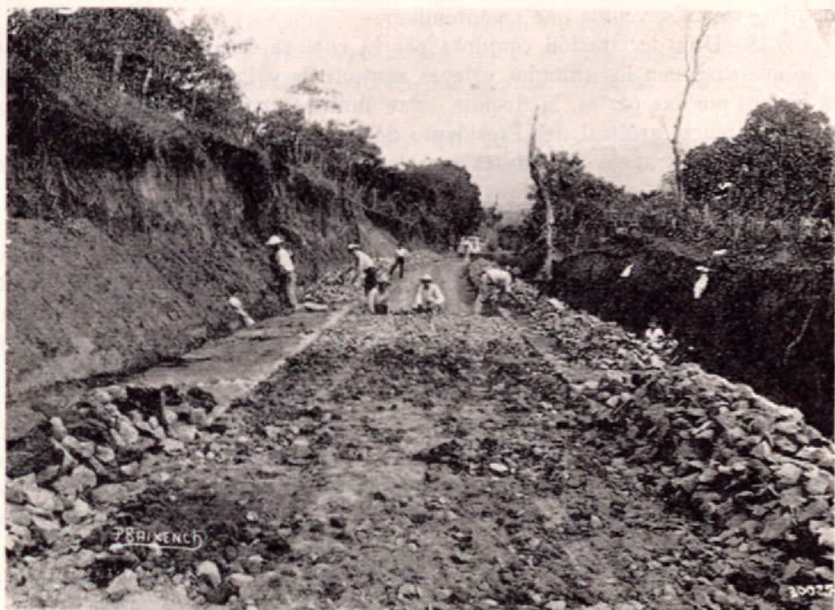
Sobre esta capa de piedra, se colocará pronto la superficie de concreto que habilita con esta carretera una rica zona del país
