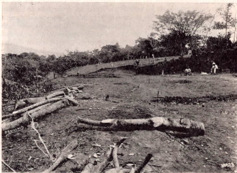
Derribada la montaña virgen, se hacen los trazos para la carretera definitiva
