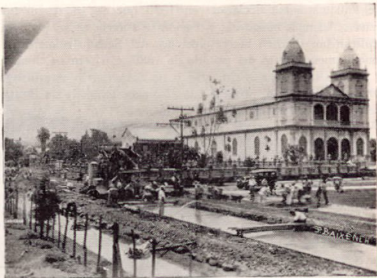
La Empresa Constructora Eric C. Murray & Co., coloca el pavimento de concreto en la sección de la carretera a Coronado, al pasar frente a la plaza de la Villa de Guadalupe.
